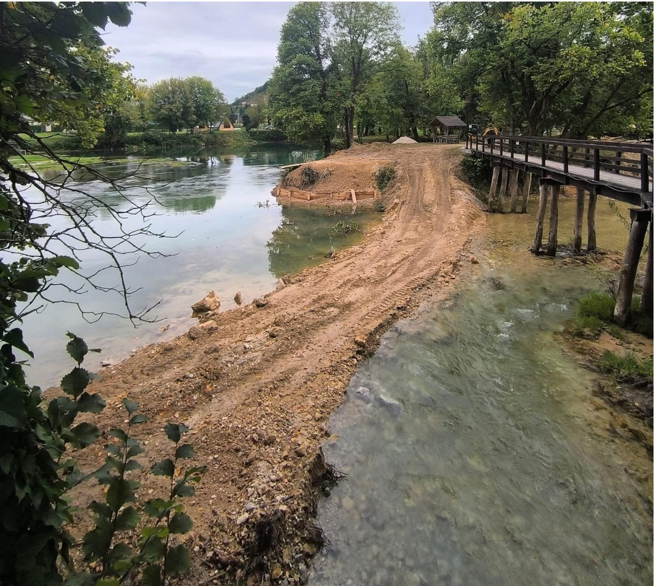
Izgradnja novog riječnog prelaza unutar doline Une. (Foto: Anes Halkic)
